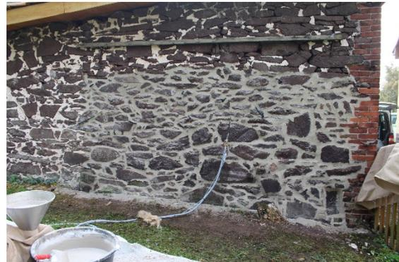
Sanierung gipshaltigen Mauerwerks mit Injektionsschaummörtel und Fugenmörtel auf der Basis des patentierten Bindemittels
